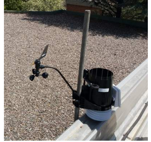
Meteoroloji İstasyonu Kurulumu
