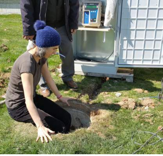
Yağmur Suyu Debi Ölçüm İstasyonu Kurulumu
